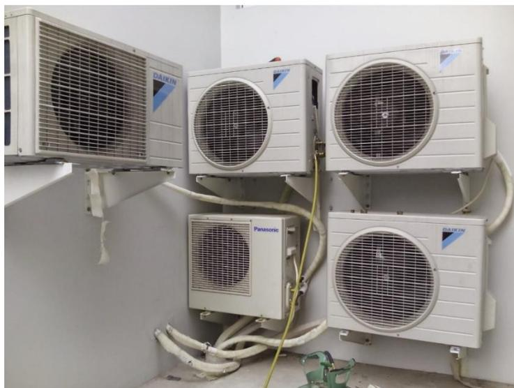
**Gambar 4.8.** Kompresor dan kondensator AC mengeluarkan hawa panas
