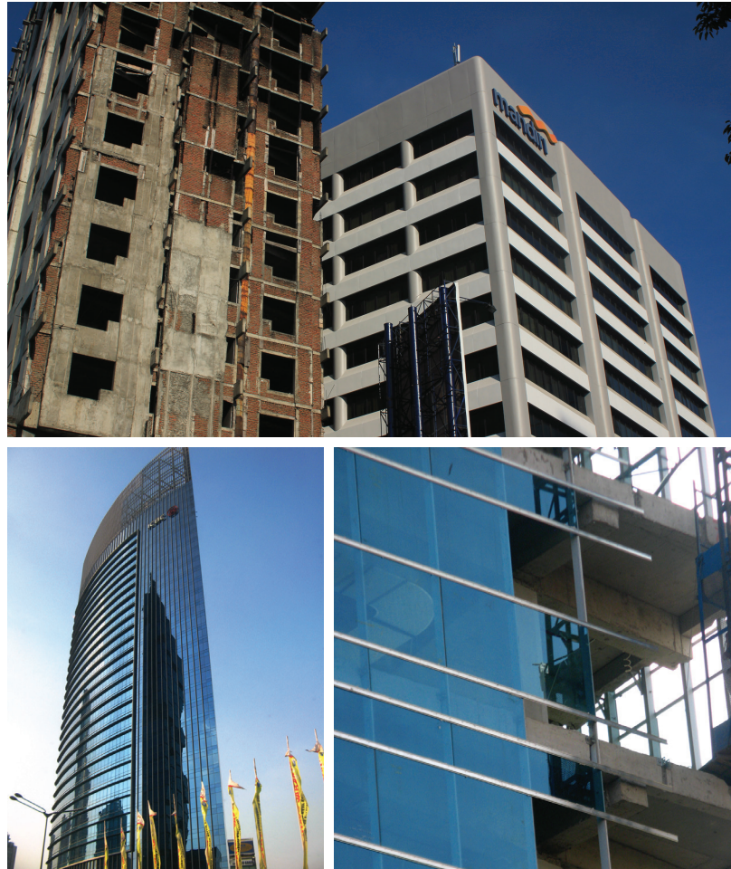
GAMBAR . 03 Konstruksi Bata dan Jendela (Kiri) dan Konstruksi Dinding Tirai Kaca (Curtain Glass Wall)
