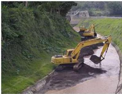
Pengerukan sedimen pada kantong lumpur secara manual/mekanis
