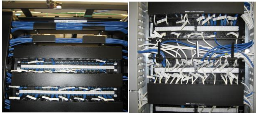
Gambar 1. Teknik HCC yang benar dan tidak benar
