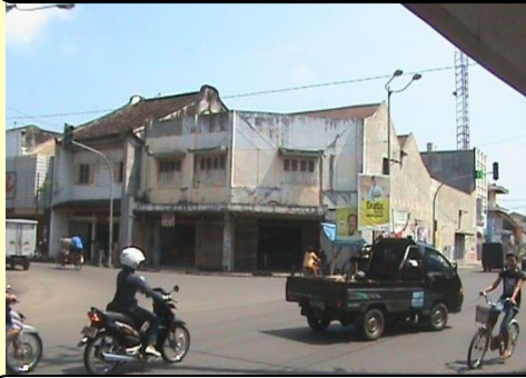
Bangunan Kuno yang kurang terawat Jl. Kapten Mulyadi
