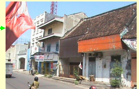
Bangunan Kuno yang kurang terawat Jl. Kapten Mulyadi
